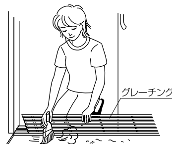
排水溝の清掃
