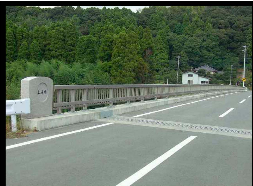
■ 町道峯之越線 上瀑橋 (千葉県)
