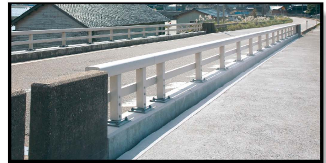
既存防護柵の老朽化にともない、現行基準に準拠したブロックアウト型の車両防護柵にリニューアル
